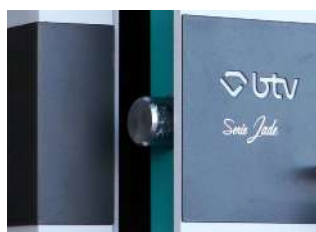
Detalle de los bulones de Ø25 mm
